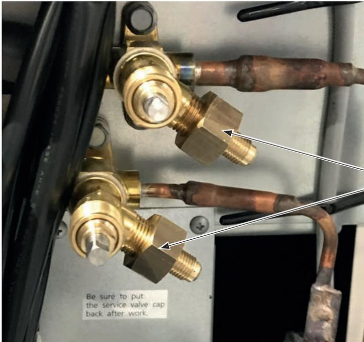
Montierte Anschluss-Adapter (Bsp.)
